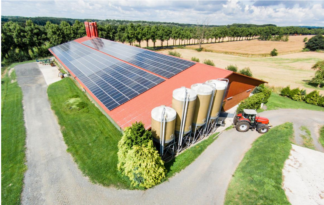
PARCO AGRISOLARE = FOTOVOLTAICO SU FABBRICATI
